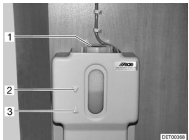
Fig. 155 Recipiente de compensación para la calefacción de agua caliente
