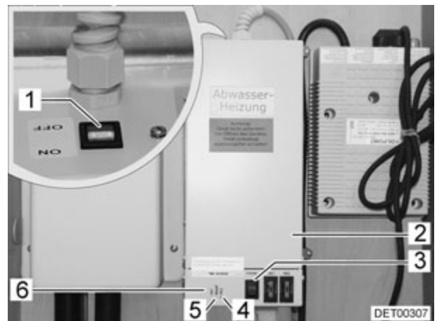
Fig. 98 Transformador con aparato regulador
