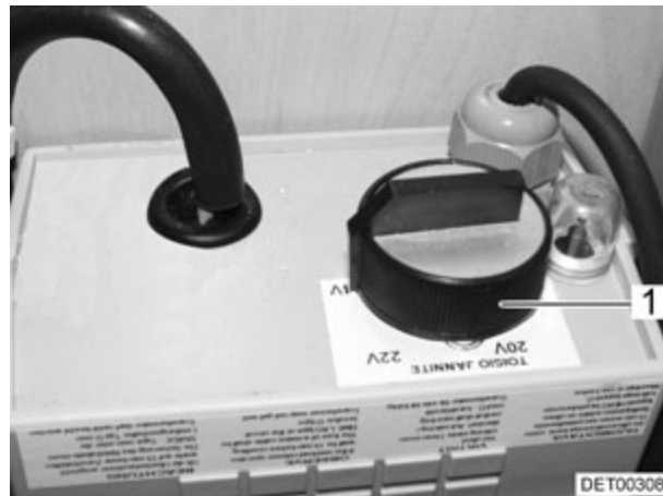
Fig. 99 Regulador para calentamiento eléctrico del piso
