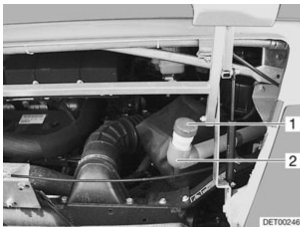
Fig. 19 Depósito de agua para lavar
