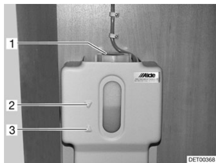
Fig. 160 Recipiente de compensación para la calefacción de agua caliente
