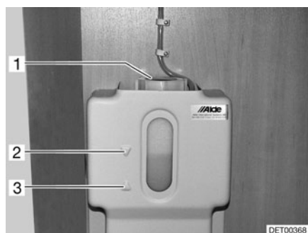
Fig. 223 Recipiente de compensación para la calefacción de agua caliente
