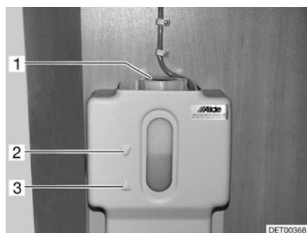
Fig. 178 Recipiente de compensación para la calefacción de agua caliente
