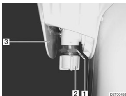
Fig. 176 Válvula del inodoro por vacío
