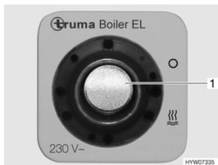
Fig. 134 Interruptor oscilante para la caldera Truma (funcionamiento con electricidad a 230 V)
