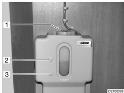
Fig. 267 Recipiente de compensación para la calefacción de agua caliente
